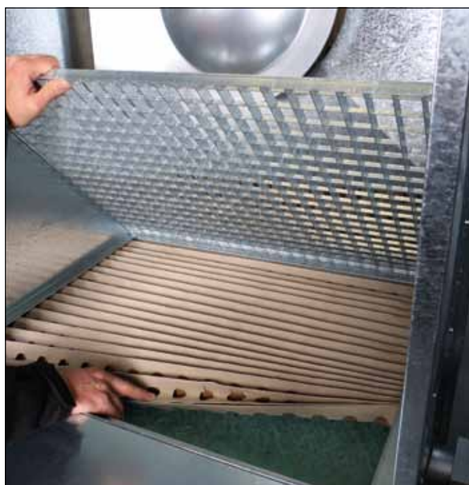
Snelle, eenvoudige filtervervangning
